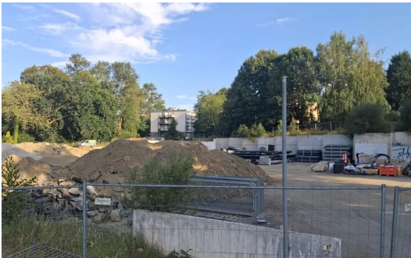
Le site de l'ancienne caserne des pompiers, déconstruite en 2022 sur le boulevard Mendès-France à Lannion, fait toujours l'objet d'un projet de construction, mais totalement repensé. (Le Télégramme/Mael
